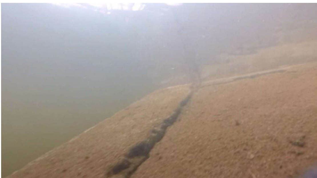
Fot. 14. Połączenie płyty żelbetowej skarpy odwodnej z przyczółkiem jazu – widoczna dylatacja (prawa strona)
