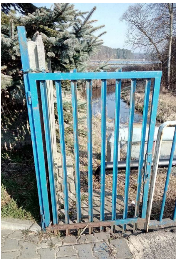
Fot.31. Widok na furtkę (lewa strona jazu) – brak komunikacji ze stanowiskiem WD jazu – niewłaściwie wykonany chodnik uniemożliwia otwarcie furtki.
