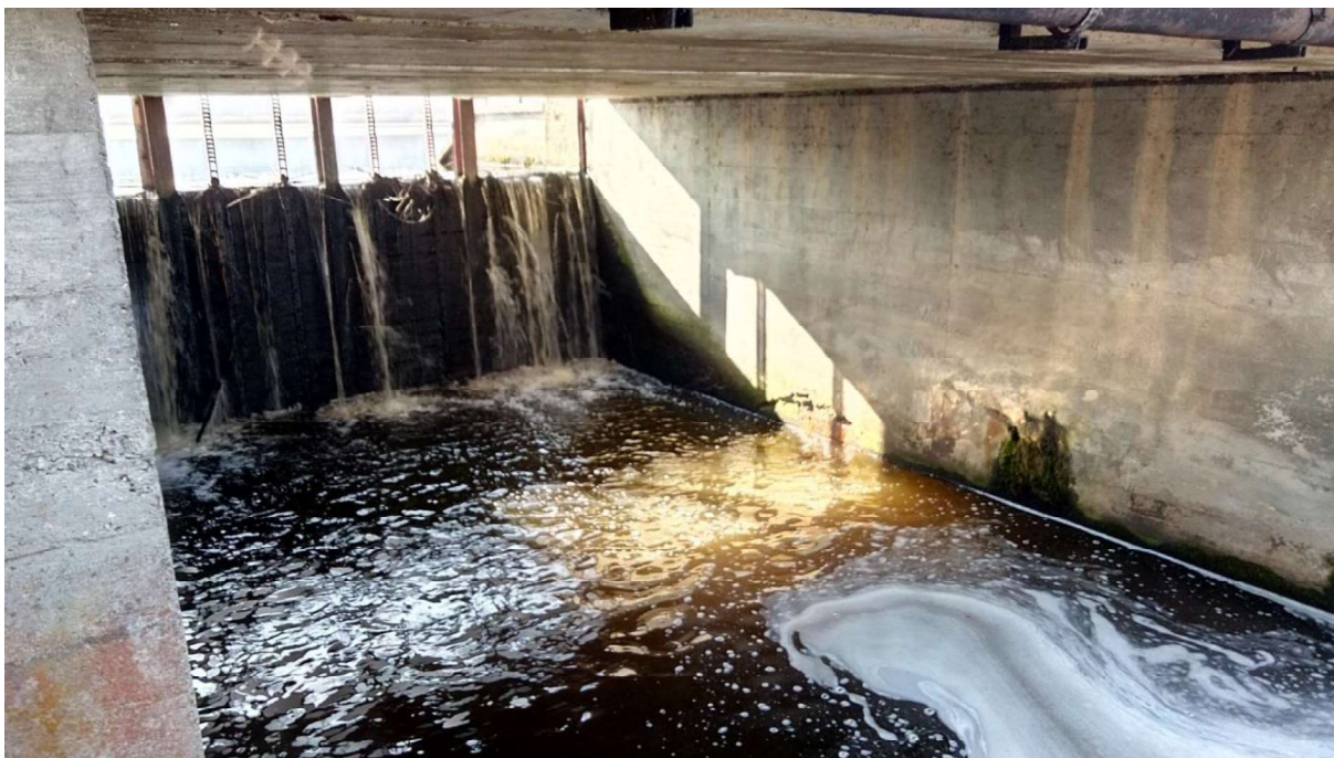
Fot. 21. Widok na zamknięcia jazu od strony WD – widoczne przesiąki przez szandory, po prawej stronie widoczne skorodowane okładziny i ubytki betonu w ścianie doku.
