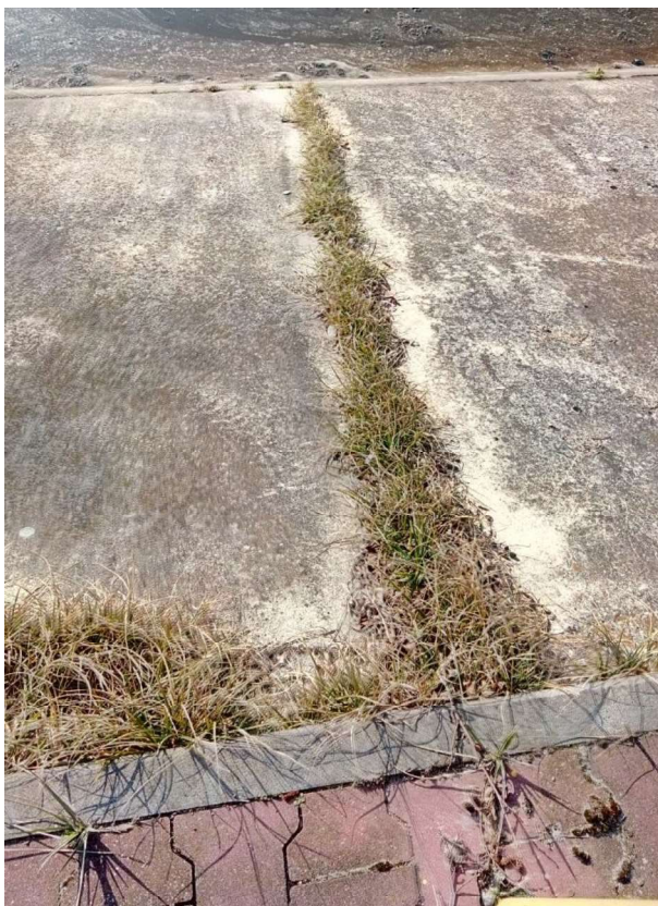
Fot.11. Widok na dylatację porośniętą roślinnością trawiastą.
