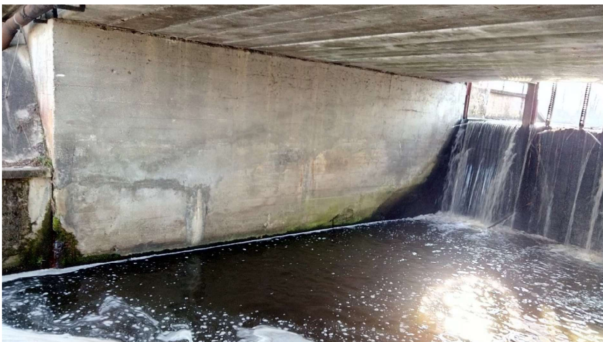
Fot. 28. Widok na prawy przyczółek jazu pod mostem – widoczne ubytki betonu i wsiąki wody na szczelinie dylatacyjnej.
