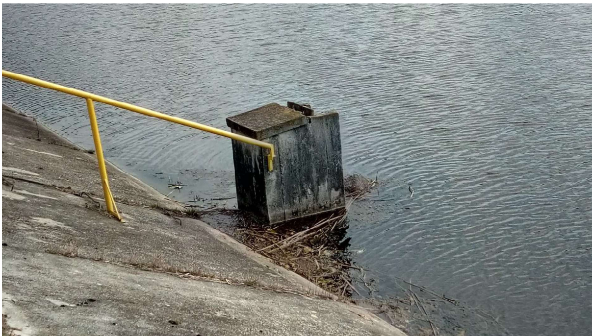
Fot.31. Widok na stojak mnicha doprowadzającego wodę do stawów.
