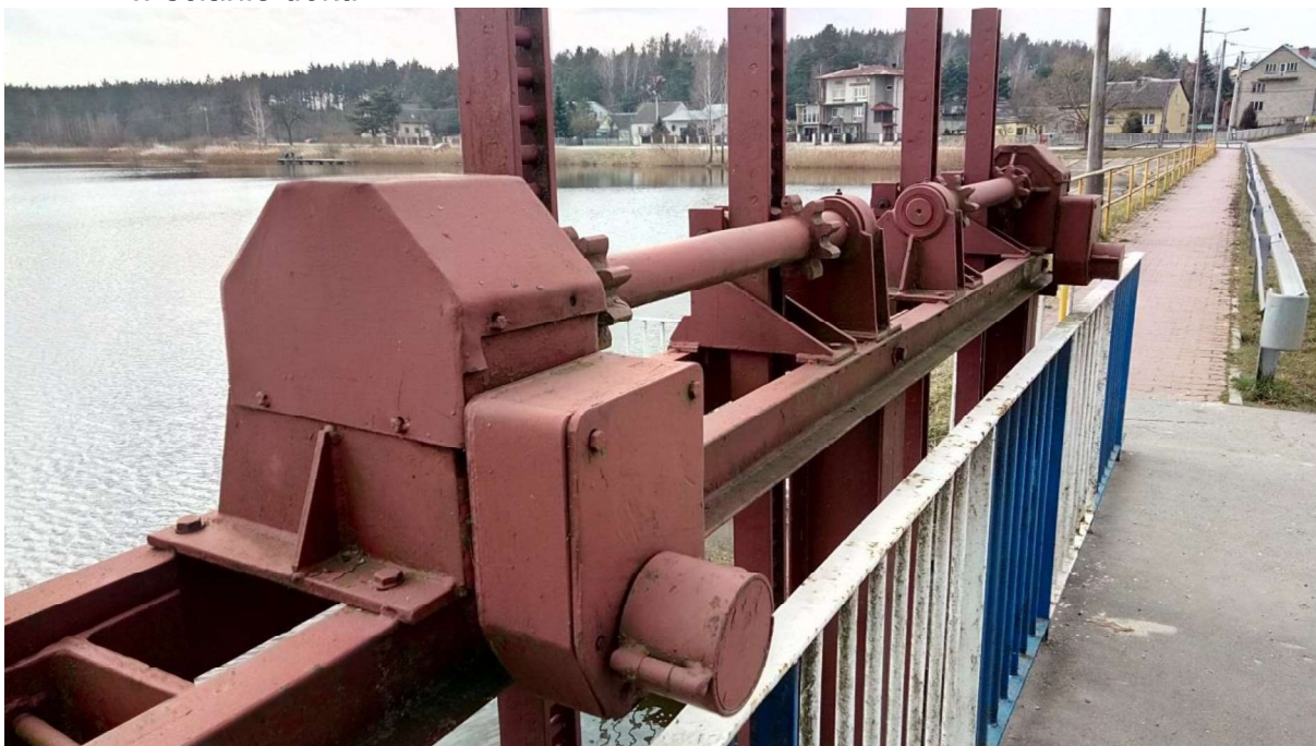
Fot. 22. Widok na mechanizm wyciągowy zamknięć jazu.
