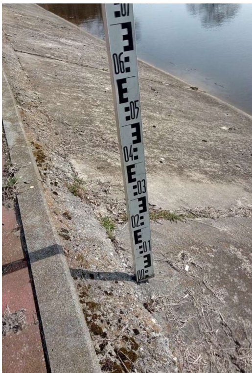
Fot.15. Lokalizacja punktów pomiarowych niwelacji podłużnej zapory ziemnej czołowej – góra płyty żelbetowej, stanowiącej ubezpieczenie skarpy odwodnej zapory.
