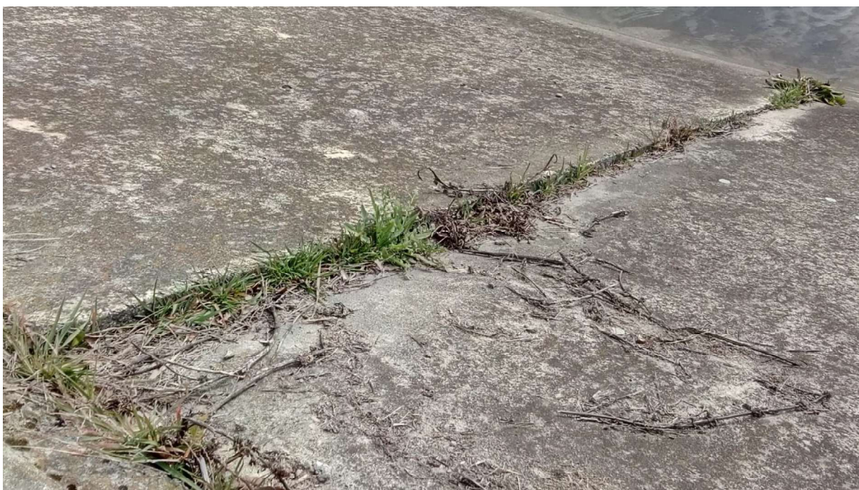
Fot.12. Widok na sklawiszowane płyty skarpy odwodnej zapory ziemnej czołowej.
