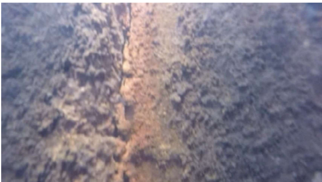
Fot. 2. Widok na dylatację lewego przyczółka jazu poniżej mostu (wykruszenie krawędzi płyt)
