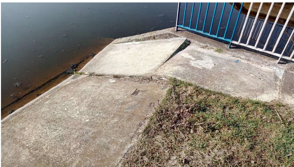
Fot.10. Rejon prawego przyczółka jazu od strony WG. Widoczne zapadnięcie betonowego ubezpieczenia skarpy odwodnej zapory czołowej.
