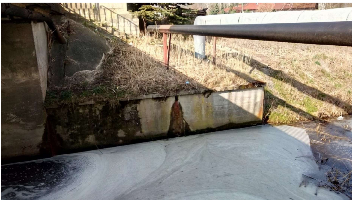
Fot. 26. Fragment lewego przyczółka jazu poniżej mostu (od WD) – widoczne wsiąki wody na przyczółku i dylatacji.
