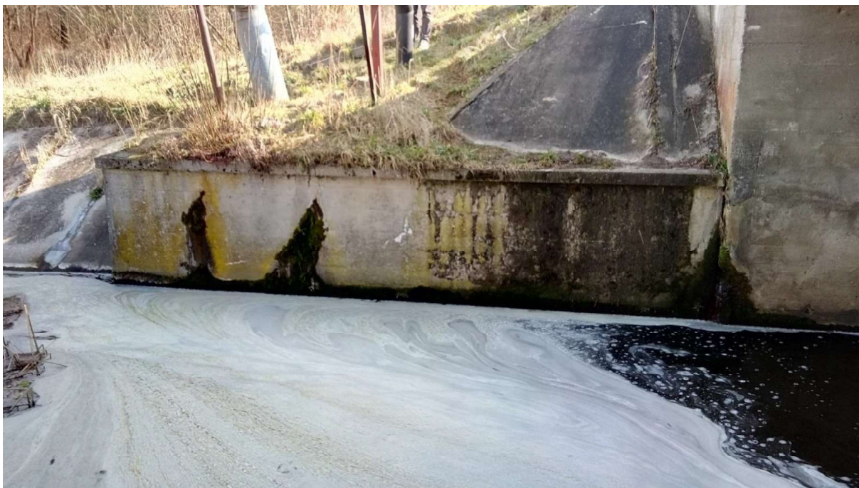
Fot. 25. Fragment prawego przyczółka jazu poniżej mostu (od WD) – widoczne wsiąki wody na przyczółku i dylatacji.
