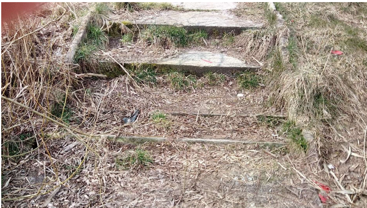
Fot.33. Widok na zapadnięty dolny stopień schodów na wejściu na pomost kajakowy.
