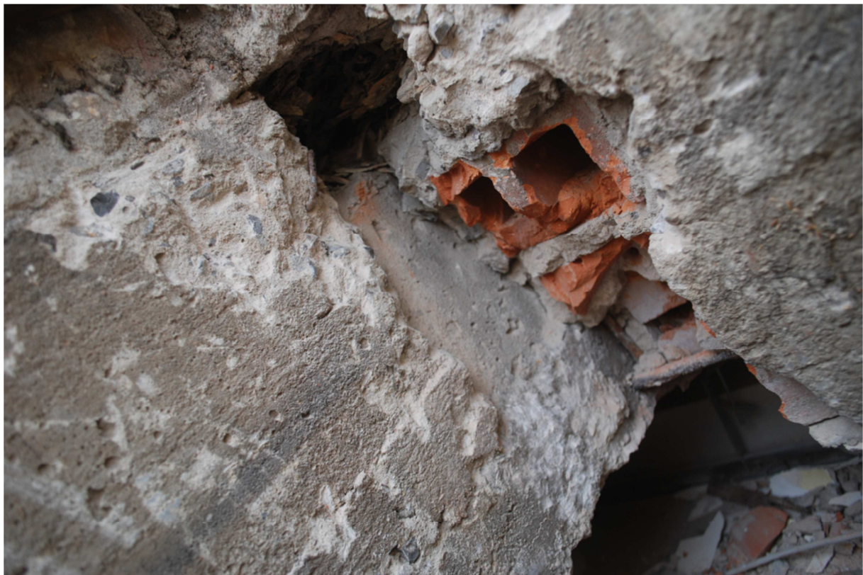
Zdj. 6 - Warstwy konstrukcyjne stropodachu w miejscu wylazu dachowego
