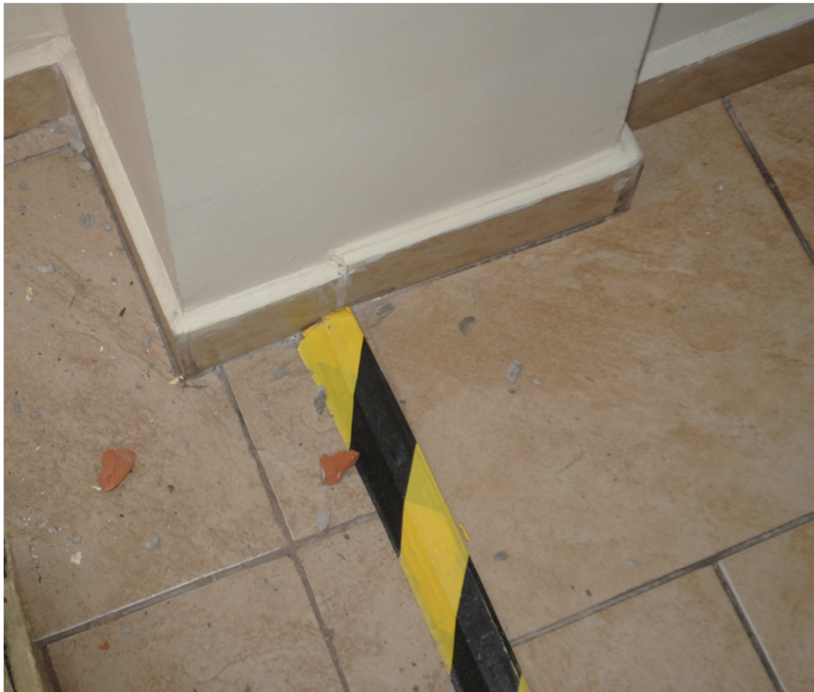
Zdj. 5 - Uskok posadzki pomiędzy klatką schodową, a korytarzem prawej części budynku
