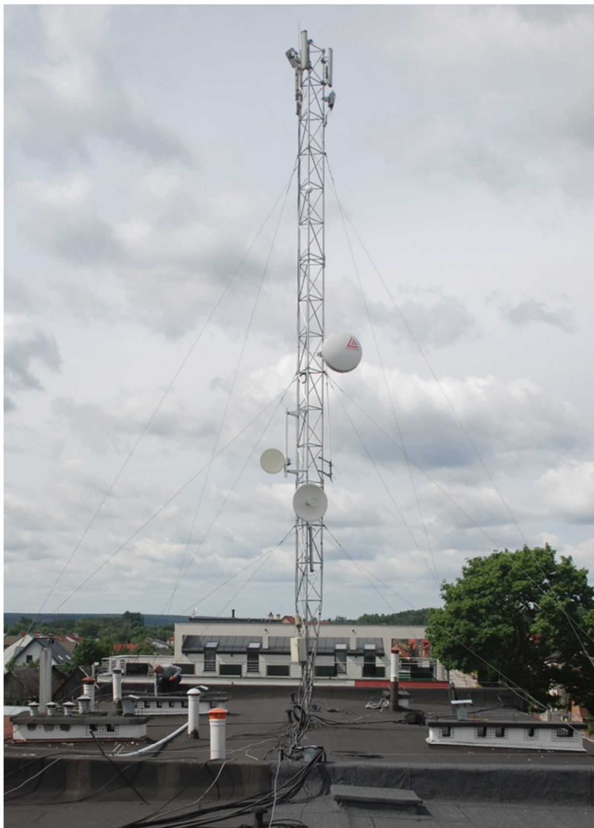
Zdj. 4 - Maszt stalowy umieszczony na stropodachu w prawej części budynku
