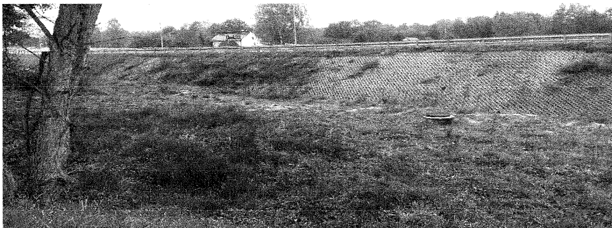
Fot. 9 rurowciąg tłoczny kolektor sanitarny KSIV
