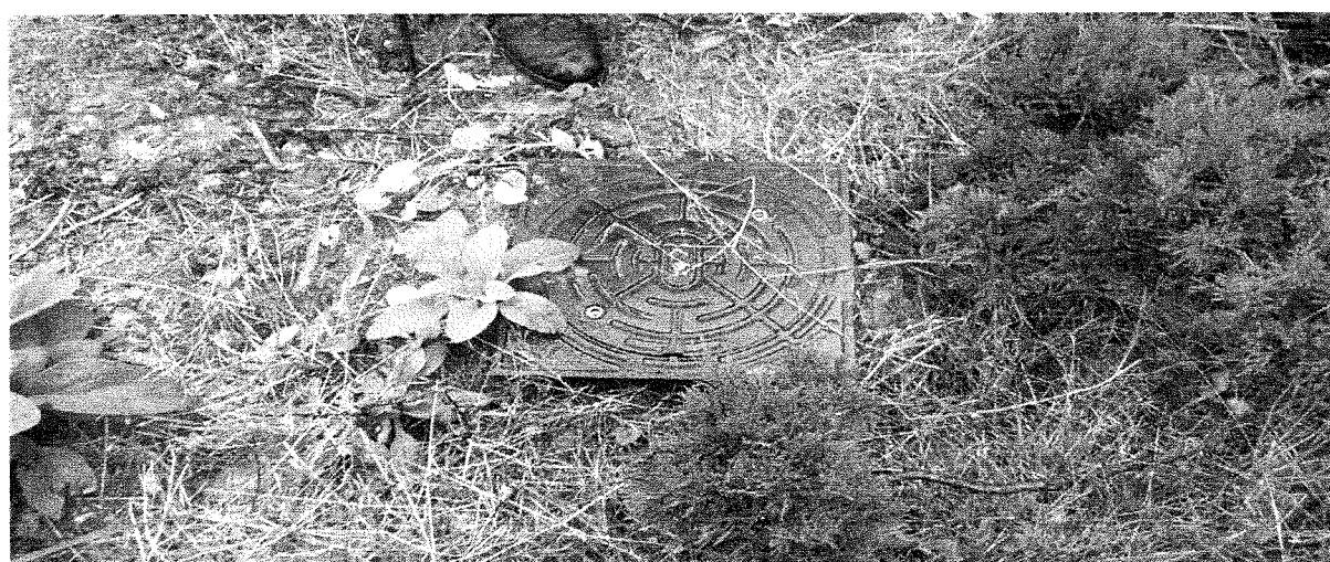
Fot. 6 przykanalik KSA
